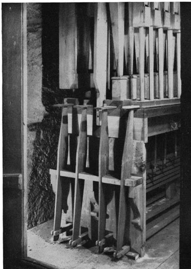
Abb. 2. Windlade mit Holzpfeifen (Baßpfeifen)
